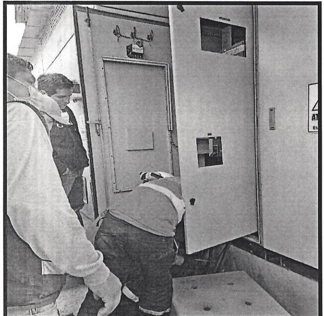
Empalme de cables que conectan el Tablero eléctrico con el grupo electrógeno externo de 600 kva.
