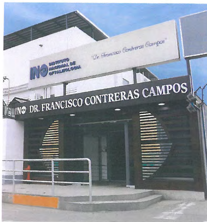
Fotografía N° 3 Puerta principal de acceso
