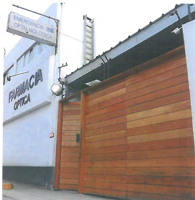
Fotografía N° 4 Puerta de acceso a Emergencia
